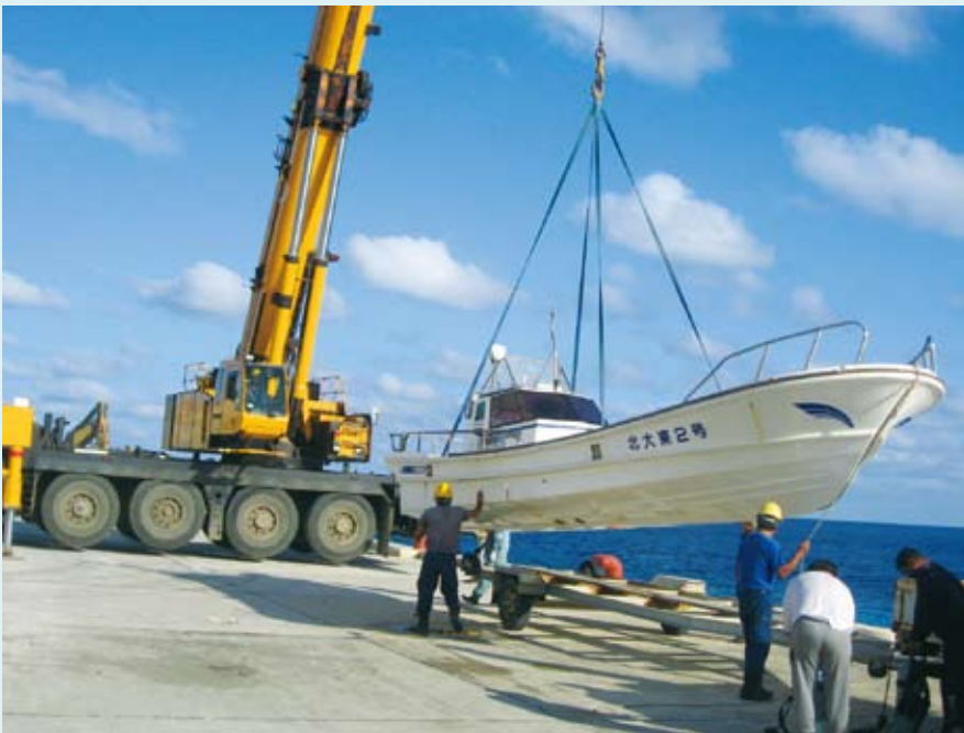
クレーンによる船舶の荷役（北大東港 江崎地区）
