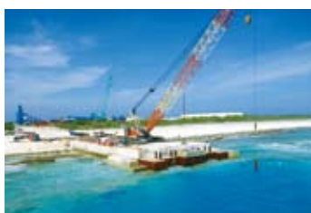
岸壁取付部 (2014年3月)
