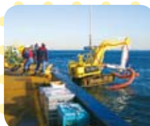
第三海堡撤去工事
