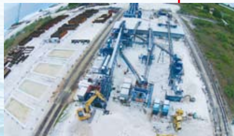
コンクリートプラント、骨材プラント、骨材置場全景 (2014年8月)
