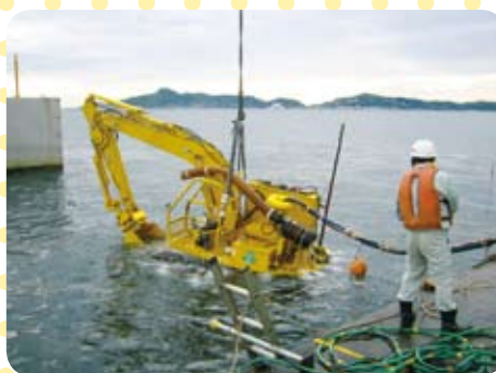
遠隔操作による均し作業実験 (長崎県神ノ島ケーソンマウンド)
